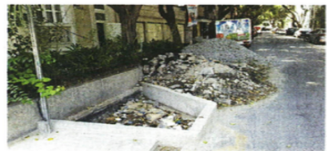
En el cruce de Valladolid y Tabasco obras del Presupuesto Participativo se encuentran pausadas.
