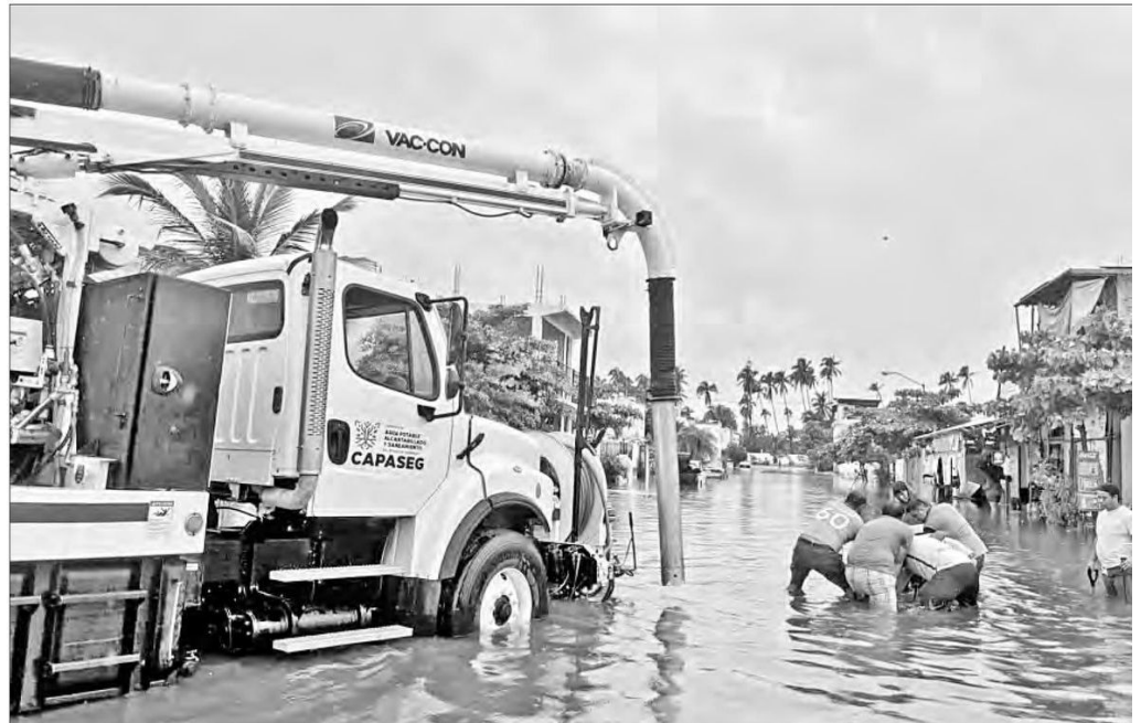
▲ Trabajadores del gobierno de Guerrero atendieron las vialidades afectadas en Acapulco, luego de las inundaciones provocadas por las lluvias de la tormenta tropical John .
