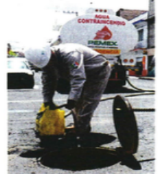
La limpieza de ductos del drenaje y sustitución de tierra continúan.
