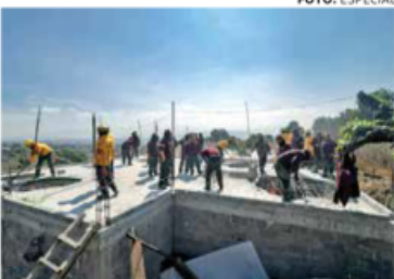
● OPERATIVO. Retiraron 44 construcciones.
