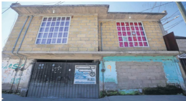
La calle Yaquis se encuentra en una de las zonas que fue severamente afectada por la inundación de aguas negras. Ahí está la casa de Valente y su familia.
