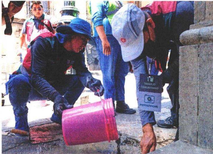
Jorge Zamora fue sancionado con diversas labores en espacios públicos, entre ellas, resanar parte de la banquetta en la calle Justo Sierra.
