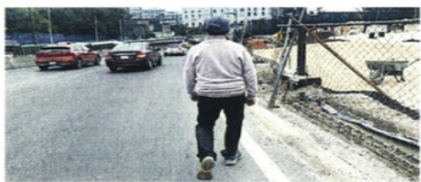
En el Kilómetro 14.5 de la Carretera México-Toluca, los peatones se ven obligados a caminar sobre el arroyo vehicular.
