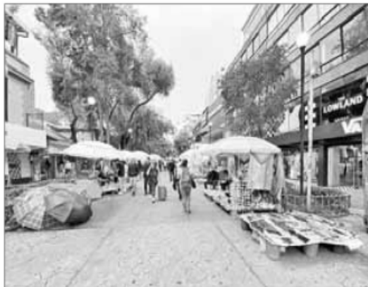
Aspectos de las calles Génova y Florencia, en la colonia Juárez, dentro del perímetro conocido como la Zona Rosa. La primera está invadida por decenas de puestos ambulantes, mientras la segunda muestra el deterioro de edificios. Fotos Germán Canseco
