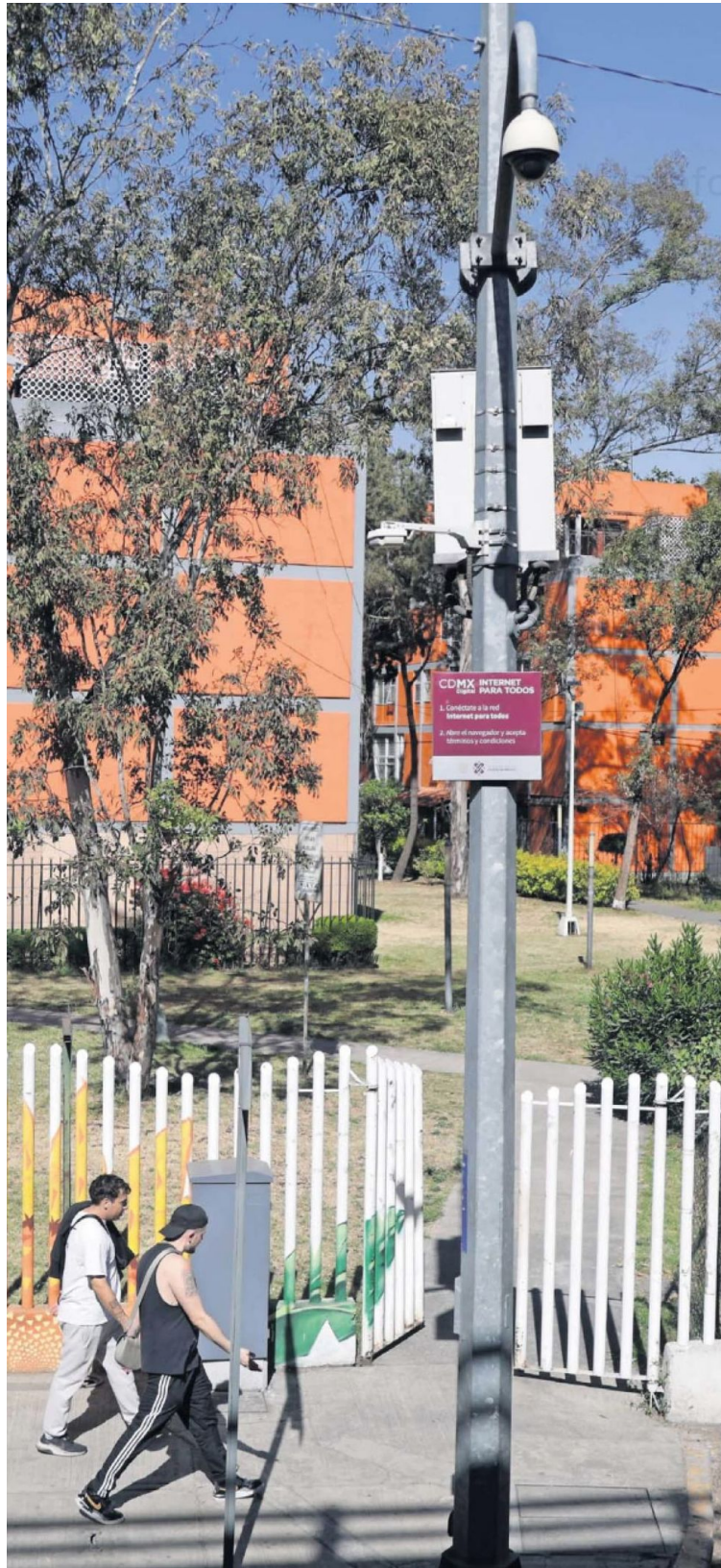
Aunque se reportan fallas en los equipos del C5 distribuidos en las 16 alcaldías, en tres se concentran el mayor cúmulo de reportes: Gustavo A. Madero, Cuauhtémoc e Iztapalapa.
