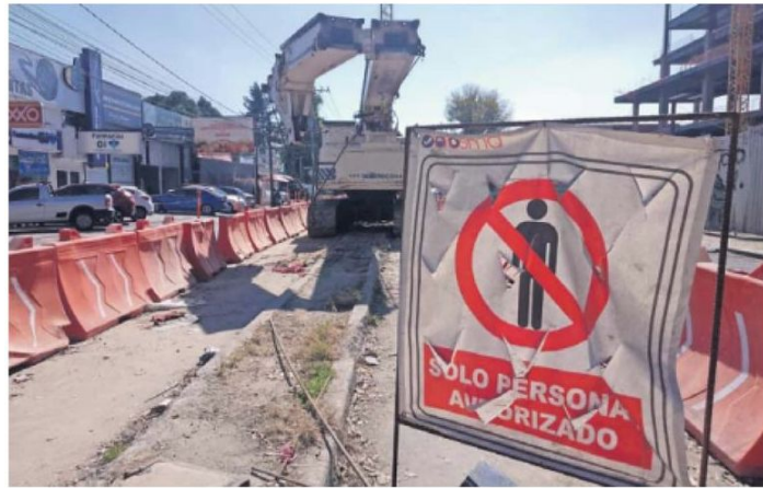
La obra vial que se edifica sobre Calzada de Las Armas, entre el Edomex y la CDMX, sigue detenida por los vecinos inconformes.
