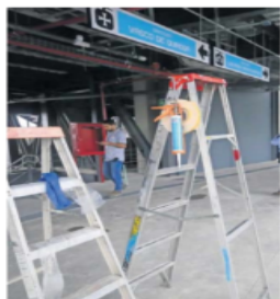
En varias estaciones trabajadores continuaban con las obras.
