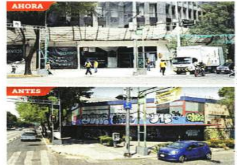
El acceso vehicular cruza por la zona de espera de peatones.
