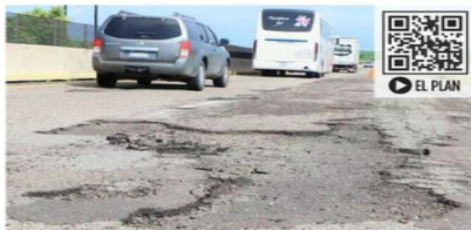
Las obras del Tren Maya dejaron casi mil kilómetros de carreteras dañadas, según datos de la SICT.
