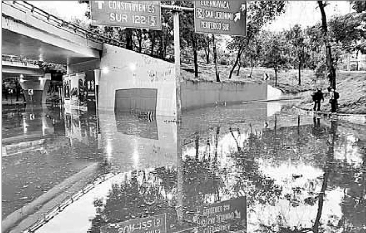
► Anillo Periférico, en su entronque con avenida San Antonio, fue una de las zonas donde más se resintió la fuerte lluvia que ocasionó anegamientos, por lo que se cerró el paso a vehículos. Foto La Jornada
