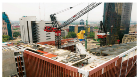
Aspectos de la construcción del AGA, obra que recientemente fue visitada por la jefa de Gobierno electa, Clara Brugada.
