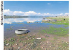
Los daños en la zona de presa de Villa Victoria son irreparables, dicen pobladores.
