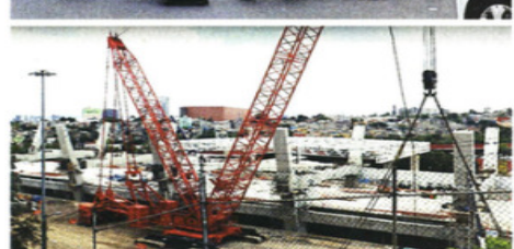
En el lugar, se construye la estación del Tren Interurbano.
