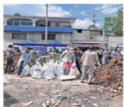
Se prevé colocar 3 mil 500 costales en la colonia Ejidal San Isidro.
