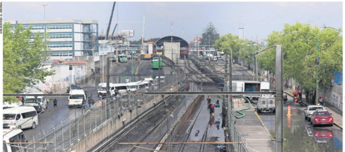
El agua de lluvia se estancó en el cajón de vías del tramo La Paz-Los Reyes, en la Línea A del Metro, por lo que personal del Sistema de Transporte Colectivo trabajó en el retiro del líquido y limpieza de la estructura para reanudar el servicio.
