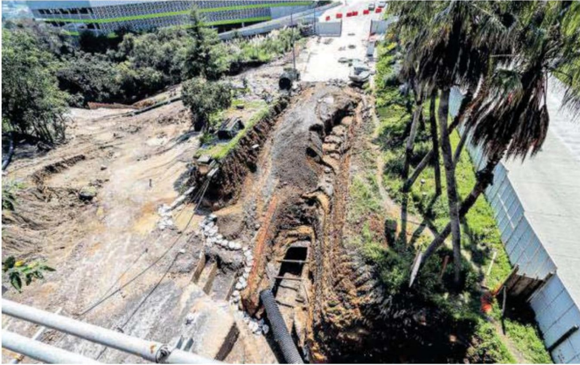
Desde la autopista Chamapa-La Venta se observa la reparación
