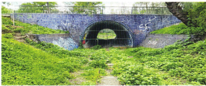
Sin uso, los túneles en la ruta se enrejaron para evitar el mal uso de esta infraestructura.
