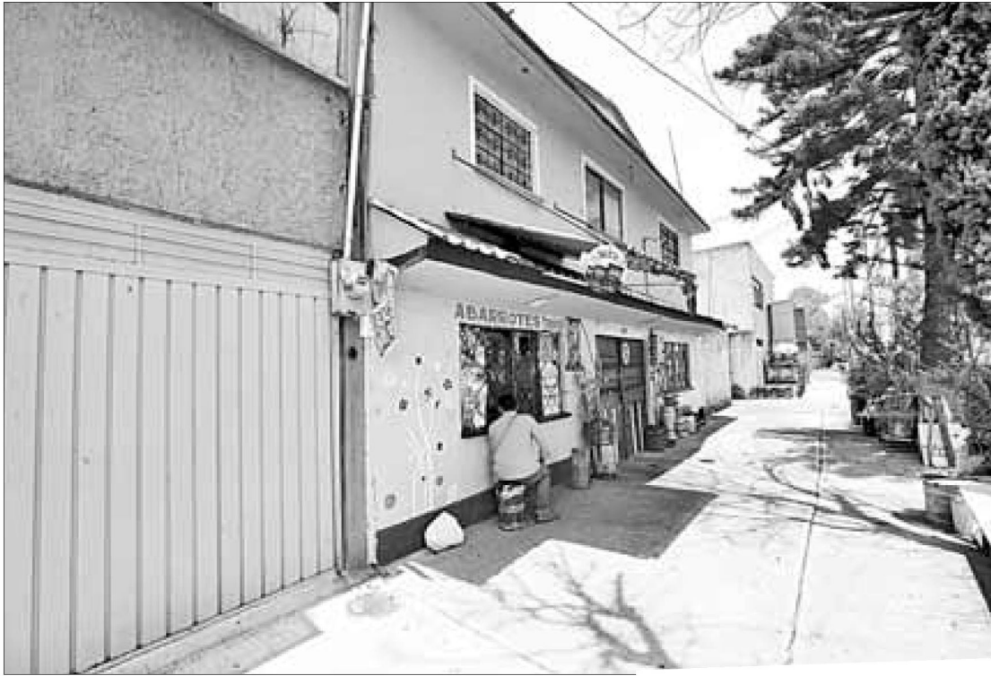
▲ El 22 de agosto de 2019, personal de la alcaldía Iztacalco detectó una toma clandestina de gasolina en la calle Añil, colonia Granjas Mexico, frente a instalaciones de Pemex. En 2023 se hizo la remediación del suelo para eliminar el hidrocarburo que lo contaminó. Fotos Alfredo Domínguez y Yazmín Ortega Cortés
