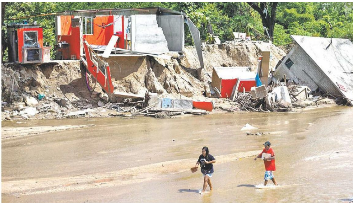
Casas en Acapulco colapsaron por el desbordamiento de un río tras las precipitaciones. CUARTOSCURO
