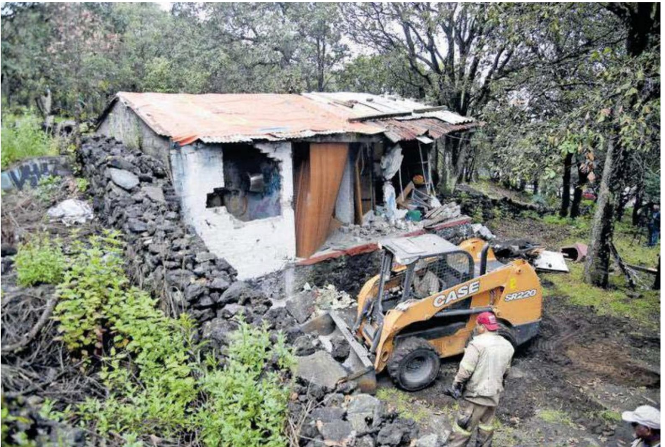
El gobierno capitalino demolió el martes dos viviendas irregulares ubicadas en el kilómetro 7+200 de la Picacho-Ajusco
