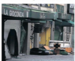
El conato de incendio se inició en la cocina, según las investigaciones.
