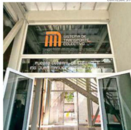
Supervisan la instalación de gabinetes electrónicos en el Puesto Central de Control II (PCC II)
