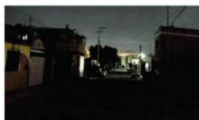
No logró colocar una tercera parte de luminarias
