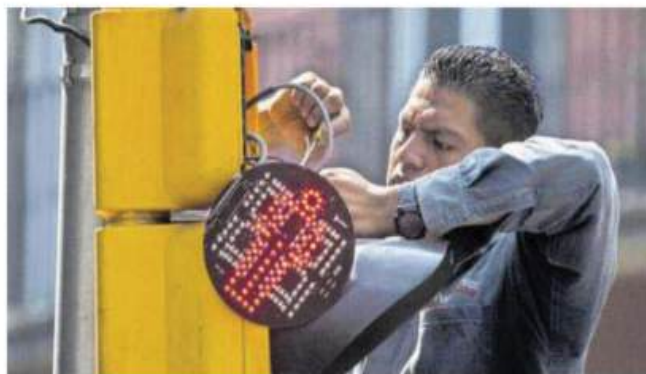
Aún no hay fecha para la modernización de semáforos.
