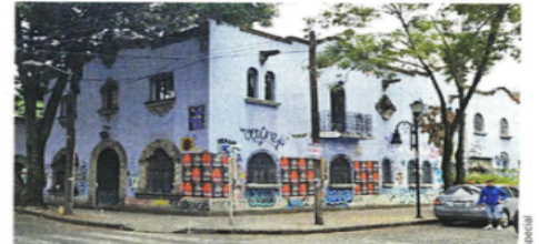
En Francisco Ortega, Coyoacán, está una de las casonas intervenida sin permisos y alterando la estructura original.
