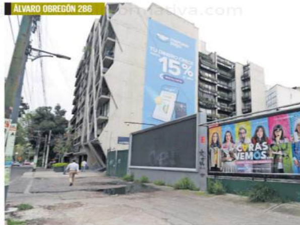
En este inmueble en la colonia Roma perdieron la vida 49 personas; ahí se planteó la construcción de un memorial que quedó en el olvido.
