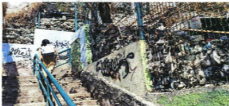
Las escaleras de los pasos peatonales fueron rodeadas por vallas para evitar que los desechos las alcanzaran.
