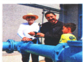
Batres dijo que el pozo S-9 estaba colapsado y por ello se rehabilitó.
