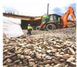
En la terminal de Pantitlán se observa material y maquinaria.
