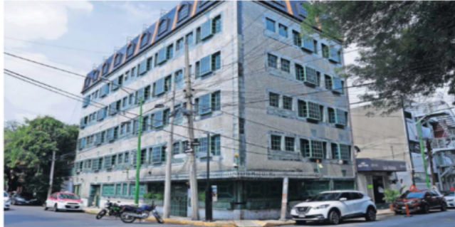
Hace unos días, autoridades capitalinas catearon un edificio ubicado en la calle Pedro Moreno, en la colonia Buenavista, relacionado con la muerte de dos jóvenes venezolanas.
