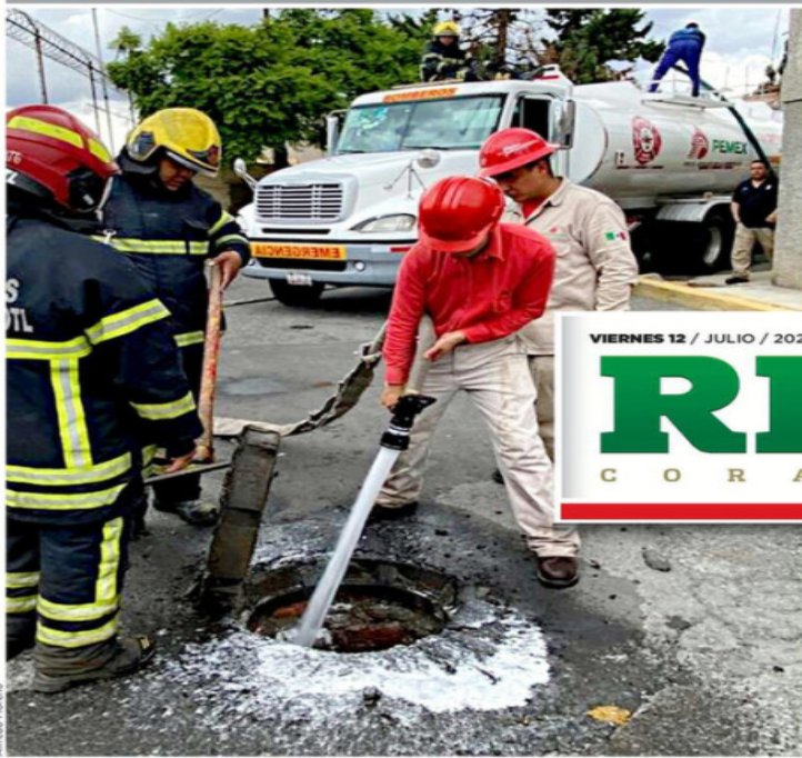
Personal de Pemex y de Bomberos continuó ayer con las labores de limpieza en el drenaje de la Colonia Ciudad Lago.
