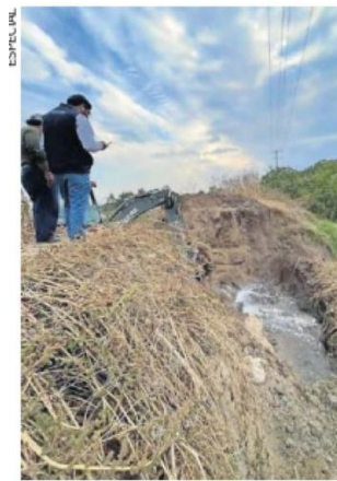
Se prevé que hoy concluyan las reparaciones del ramal afectado.
