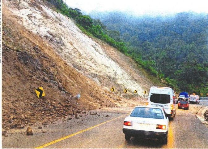
Debido a las constantes lluvias provocadas por el huracán John , en Oaxaca se registran deslaves en la nueva carretera que lleva a la costa.
