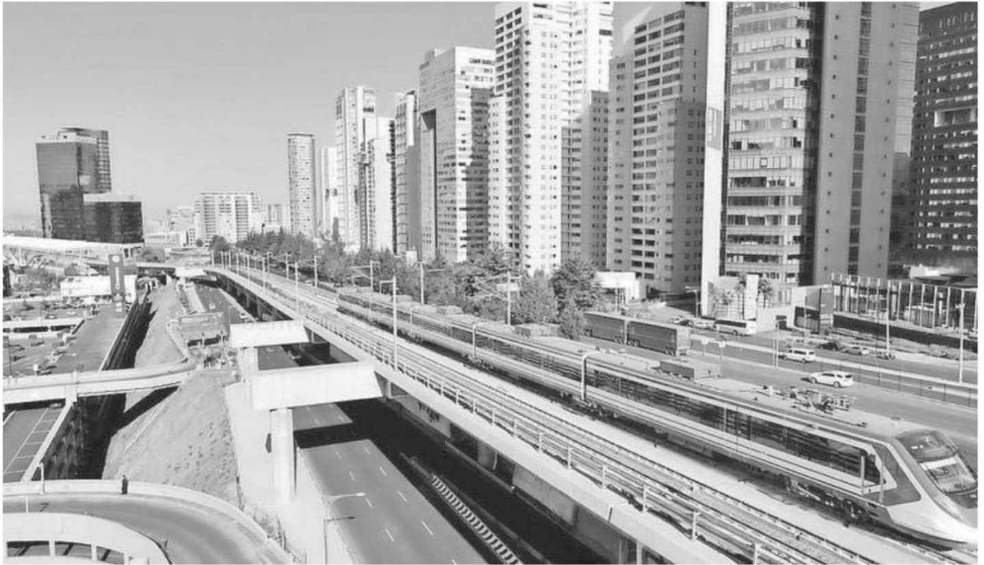
La nueva estación está del lado oriente del Centro Comercial Santa Fe, entre la avenida Vasco de Quiroga y la México-Toluca
