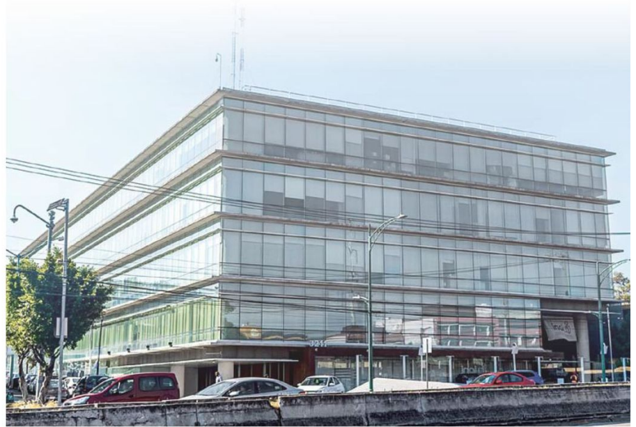
OBJETIVO. Al final del arrendamiento, el edificio del Inai puede ser comprado por 683 mil pesos.
