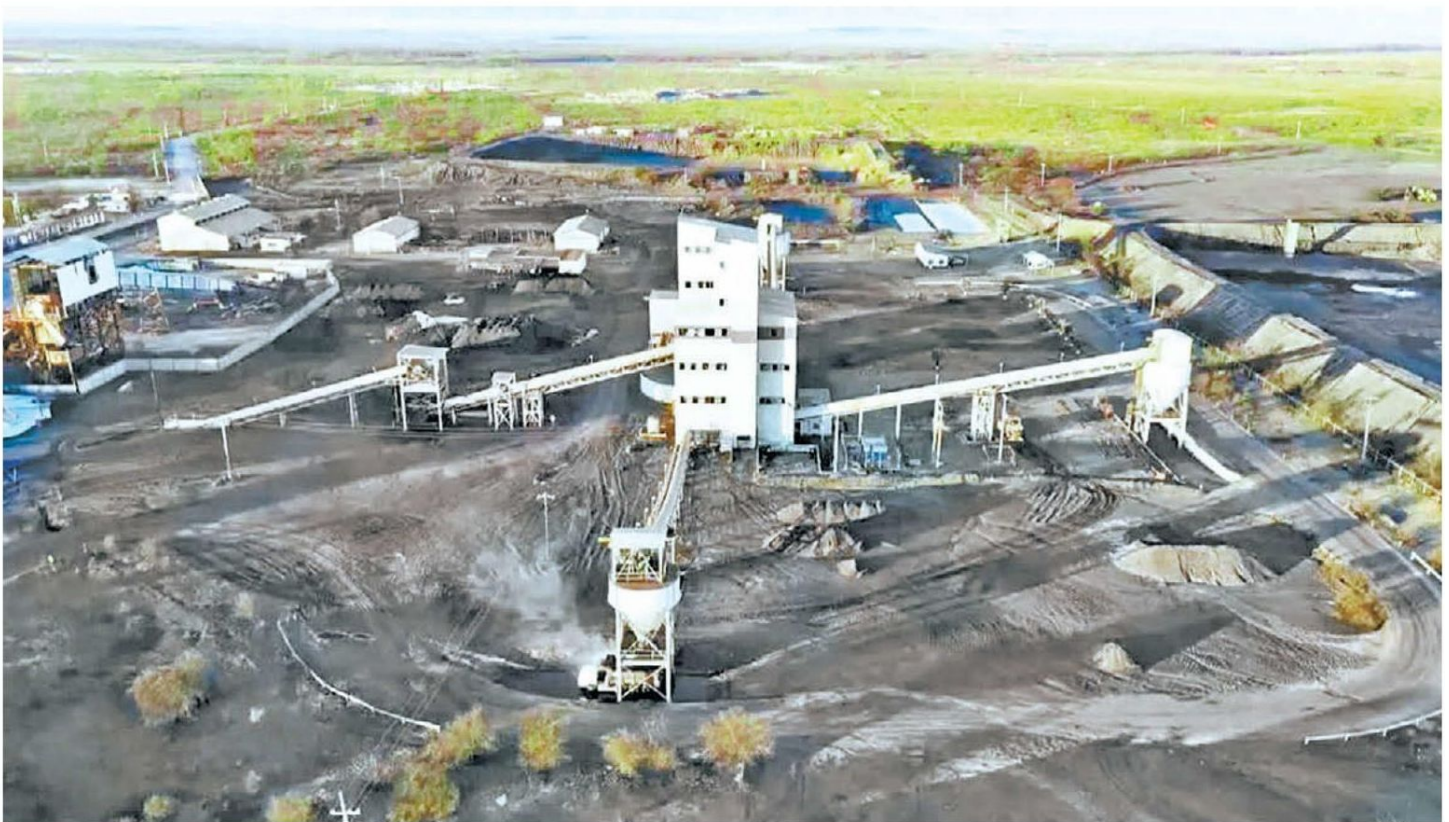
Instalaciones en el municipio de San Juan de Sabinas, Coahuila. IVÁN SÁNCHEZ
