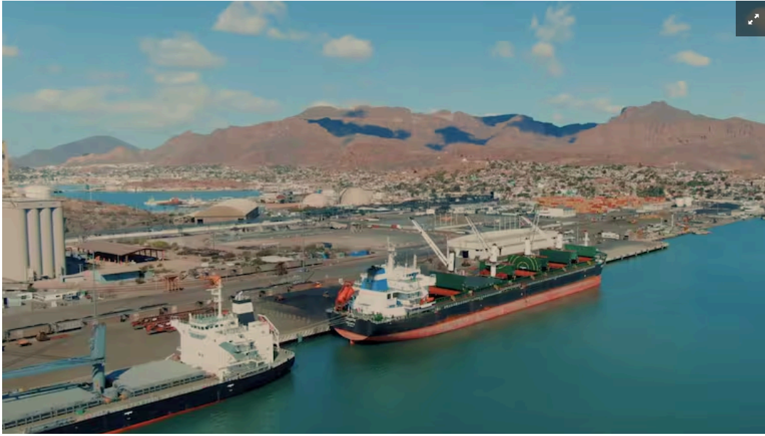
La ampliación y modernización del puerto de Guaymas es uno de los proyectos que se contemplan para el próximo gobierno federal. FOTO: BANCO DIGITAL
