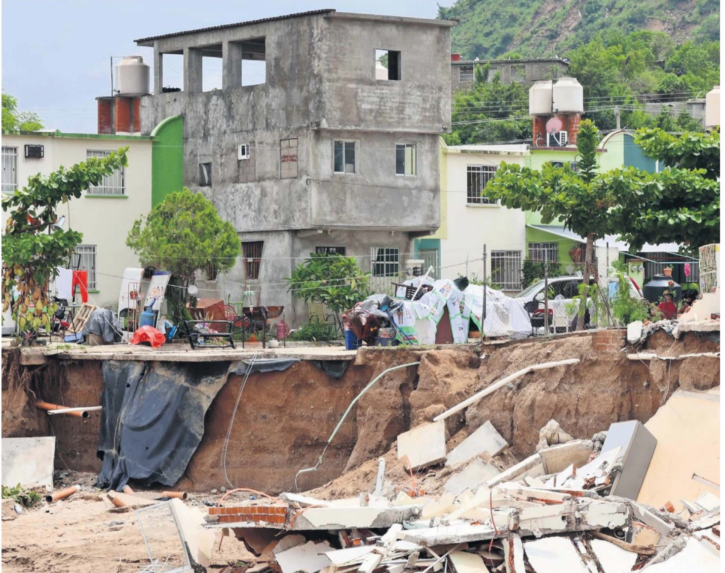
Vecinos de las colonias San Agustín, Casas Palenque y Los Órganos, ubicadas en la carretera federal México-Acapulco, piden ayuda a las autoridades tras perder sus casas.
