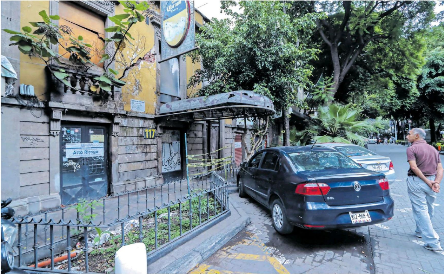
En Londres 117 , casi frente al Hotel Geneve, ya avanzó el permiso para demoler, pero aún no se lleva a cabo nfo.mx
