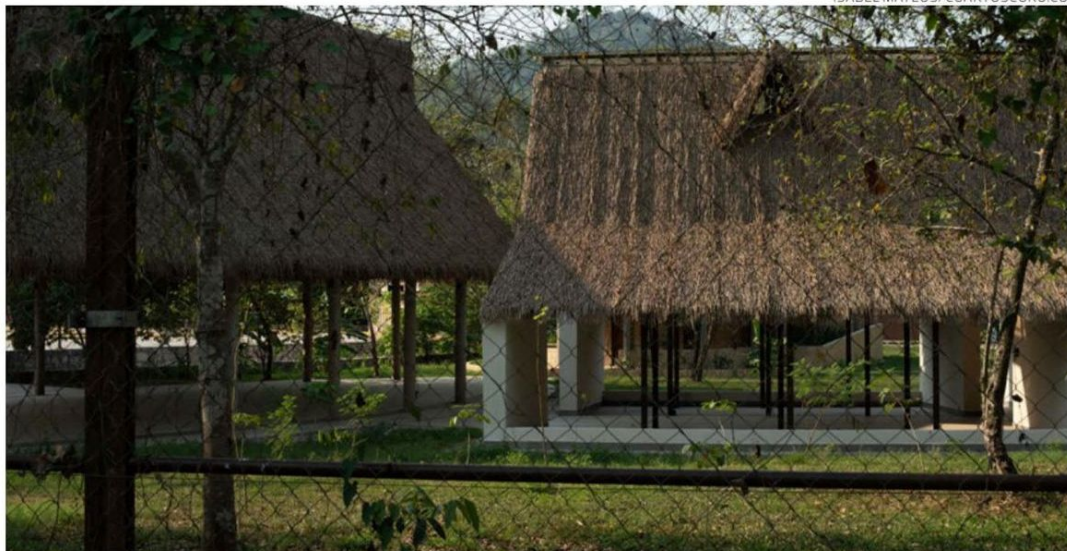
La Sedenase está construyendo la cadena de hoteles Tren Maya. En la imagen, el hotel en Palenque, Chiapas.
