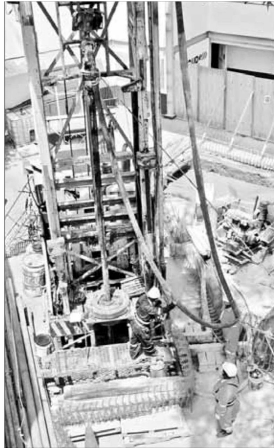
▲ El pozo Barrio del Niño de Jesús, ubicado en la alcaldía Coyoacán, es una de las obras del gobierno de la Ciudad de México y del Sacmex con las que se busca mejorar el suministro de agua en beneficio de 17 mil habitantes. Foto La Jornada
